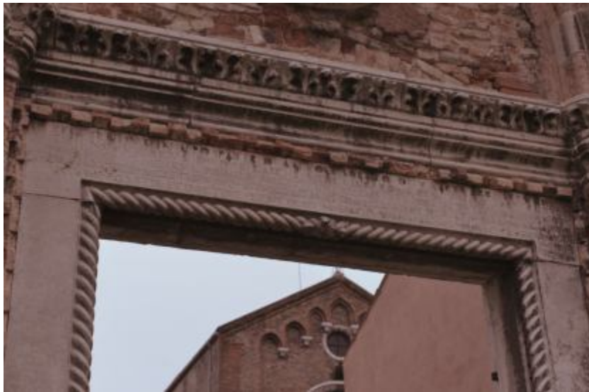
Foto 2. Dettaglio della facciata Ovest con l'iscrizione della consacrazione del 1491
