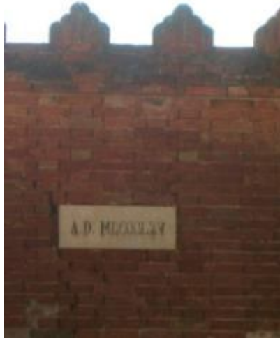
Foto 30. Lastra datata 1865 e muro perimetrale dell'Insula dei Servi
