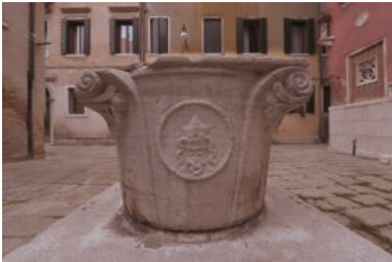
Foto 90. Vera da pozzo. Lato est.
