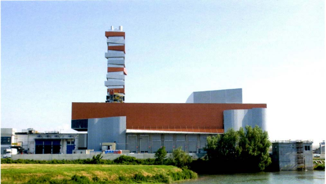
Foto 3.7. Il termovalorizzatore di Padova.
