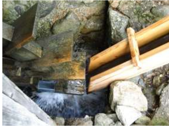
Fig. 32- Doccia inclinata in legno per portare direttamente l'acqua alla ruota Mulino di Brunico (foto Bazzani)
