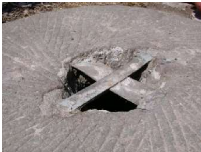
Fig. 13 - Particolare delle listarelle aggiunte quando la macina viene riutilizzata come materiale da costruzione (foto Bazzani)
