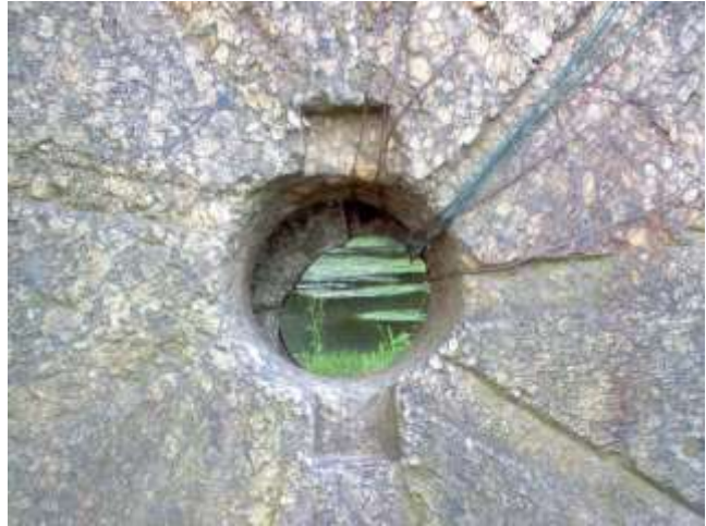
Fig. 23- particolare dell'”occhio della macina”, ben visibile l' incavo a forma di farfalla, che serve ad la nottola, mulino di Cervara (foto Bazzani)
