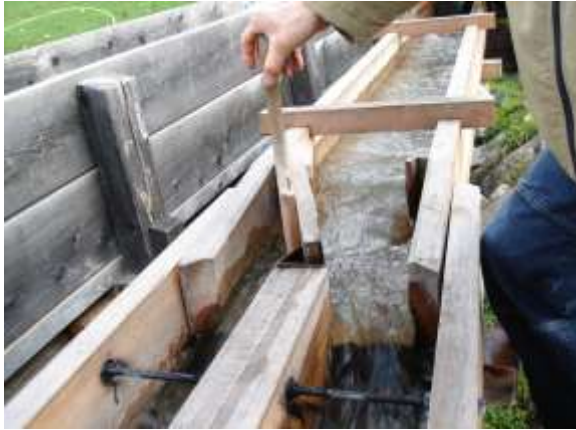
Fig. 31- Canale artificiale derivato da un fiume per portare acqua come forza motrice o per irrigare detto "gora" Mulino di Brunico (foto Bazzani)
