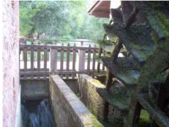
Fig. 30- Gora e saracinesche che portano L'acqua alle ruote, Mulino di Cervara (foto Bazzani)
