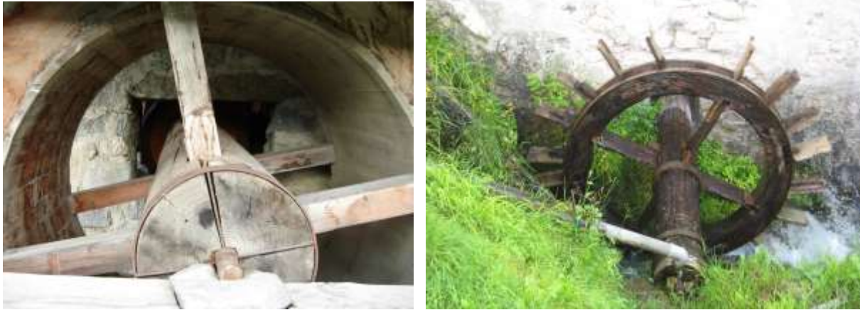
Fig. 19 - particolari dell'albero motore che dalla ruota idraulica entra nella struttura del mulino, foto a destra mulino di Brunico, foto a sinistra mulino di Casto. (foto Bazzani)
